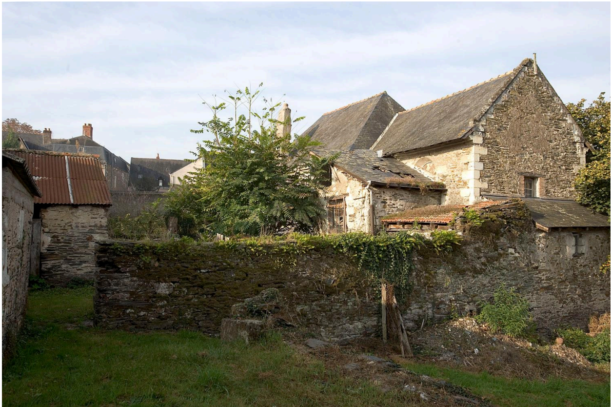
Chapelle (chevet droit et élévation latérale droite) et maison dite du Souvenir, vue d'ensemble depuis les dépendances nord de la ferme.
