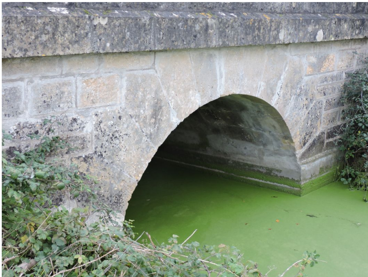
L'arche du pont, côté nord-ouest.
