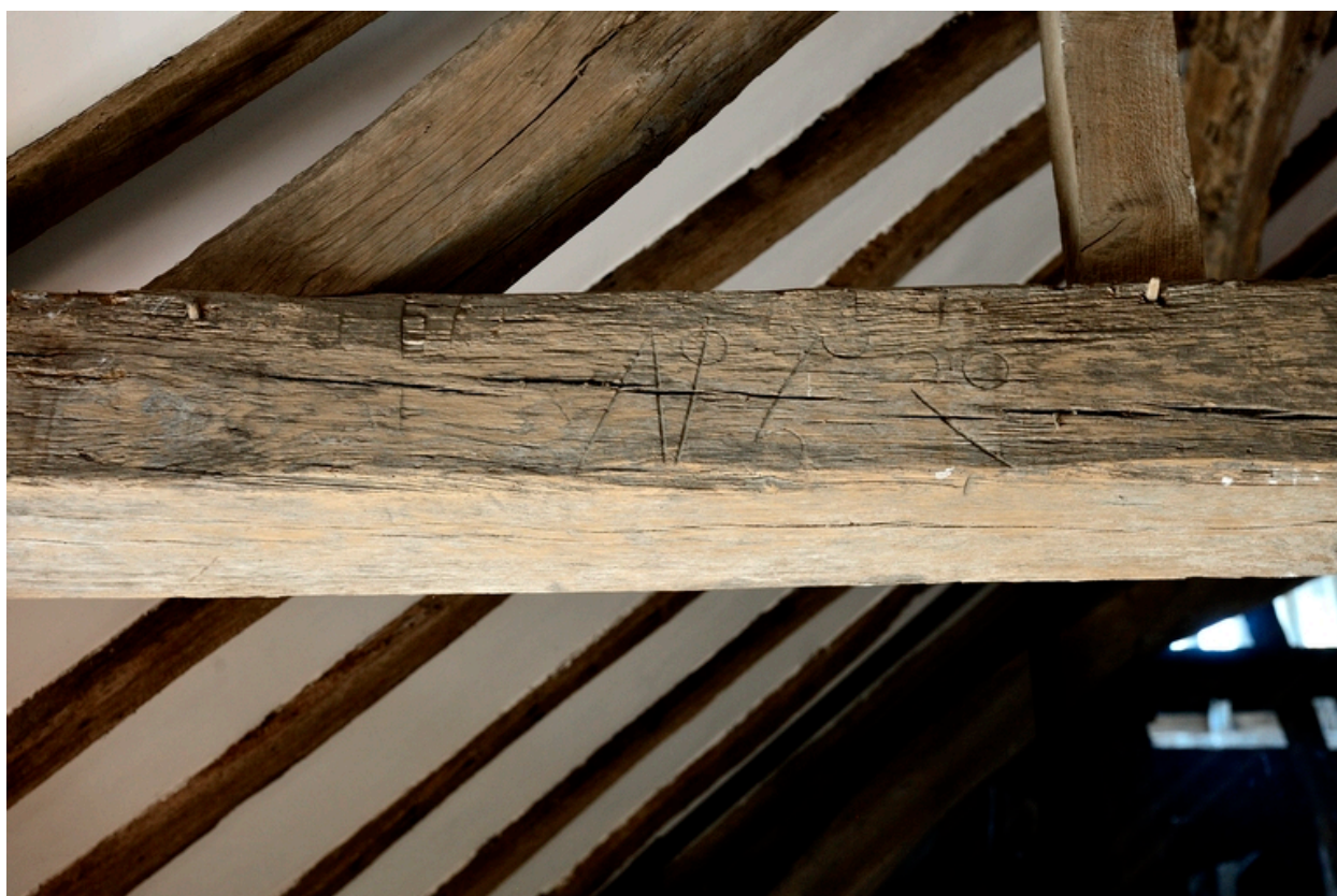
Chai. Charpente. Détail d'une marque de charpentier.
