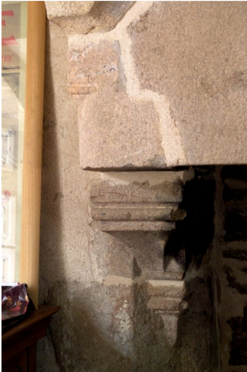
Détail du piédroit de la cheminée du rez-de-chaussée.
