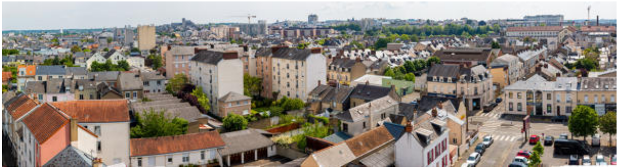
Vue de la partie sud du quartier Saint-Pavin.
