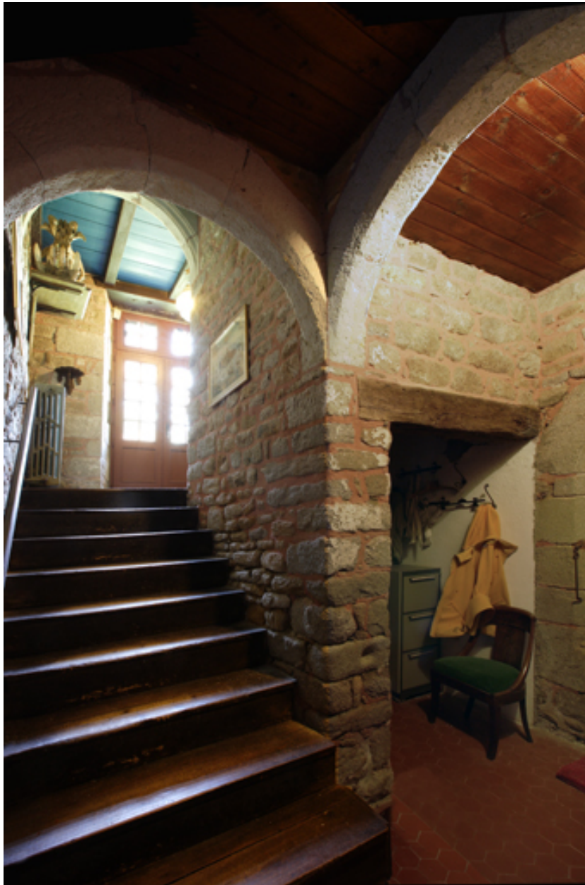
Logis. Rez-de-chaussée. Détail de l'escalier rampe-sur-rampe.
