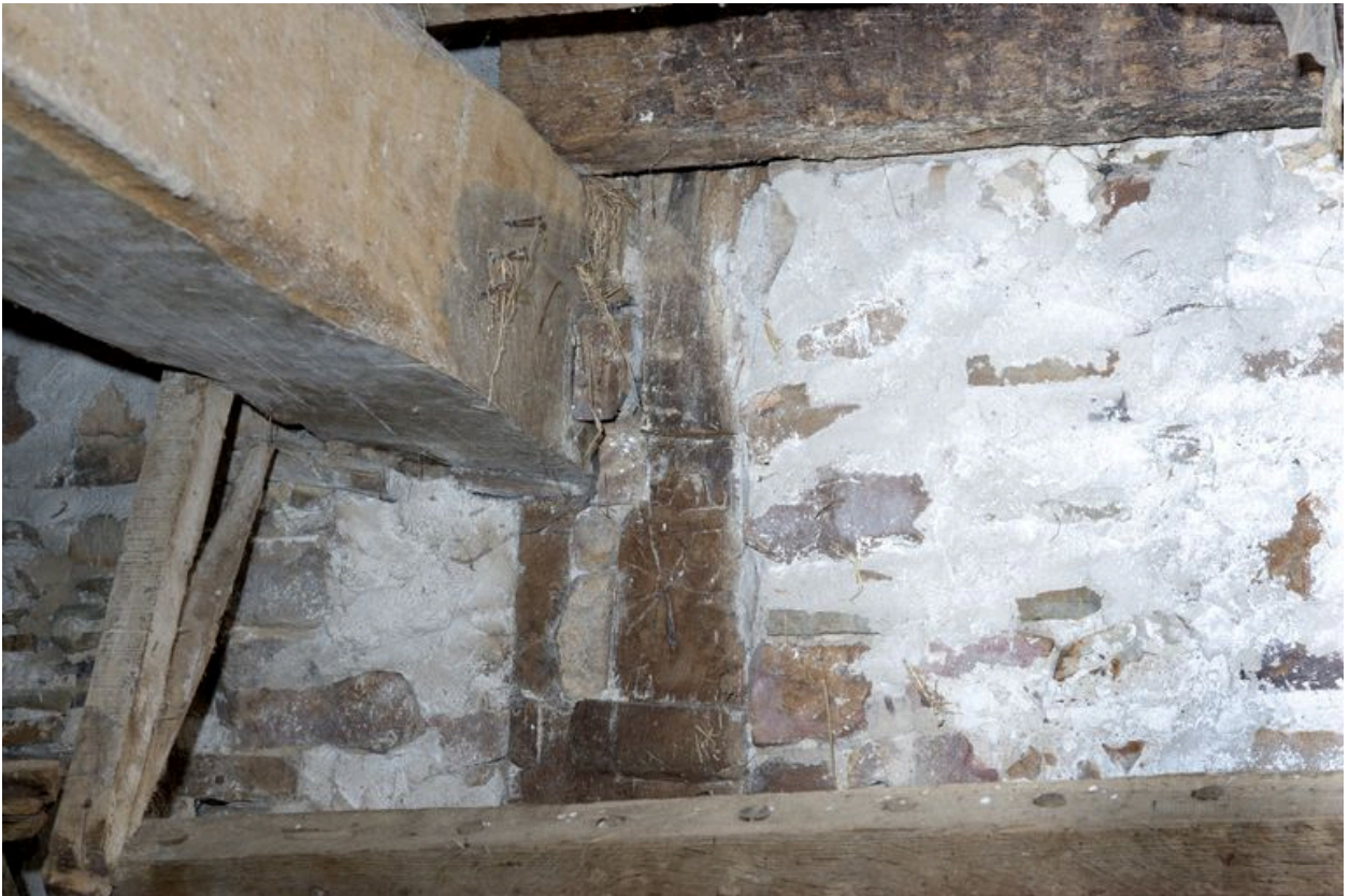
Détail du pan de bois du mur nord de l'ancien logis : la sablière, le poteau et l'entrait vus depuis l'intérieur.
