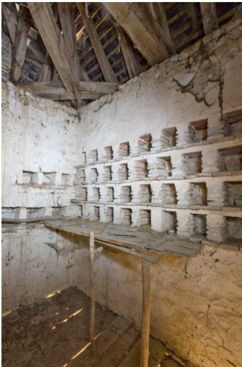
Vue intérieure de la partie supérieure du pigeonnier, montrant les boulins.
