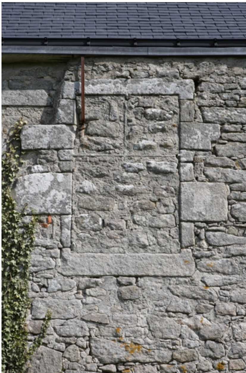
Façade sud. Premier étage. Détail de la croisée de la salle haute.
