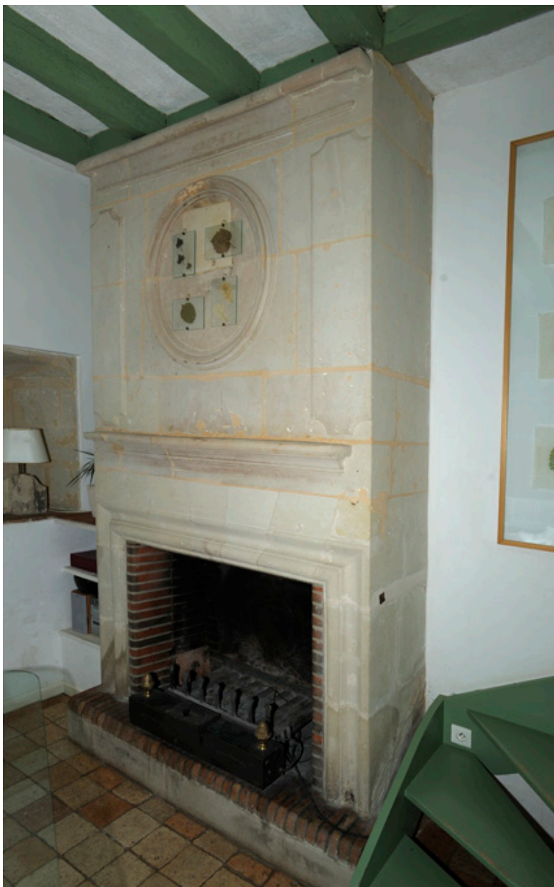
Corps de logis, rez-de-chaussée, salle nord : cheminée du XVII e siècle (remaniée ?).
