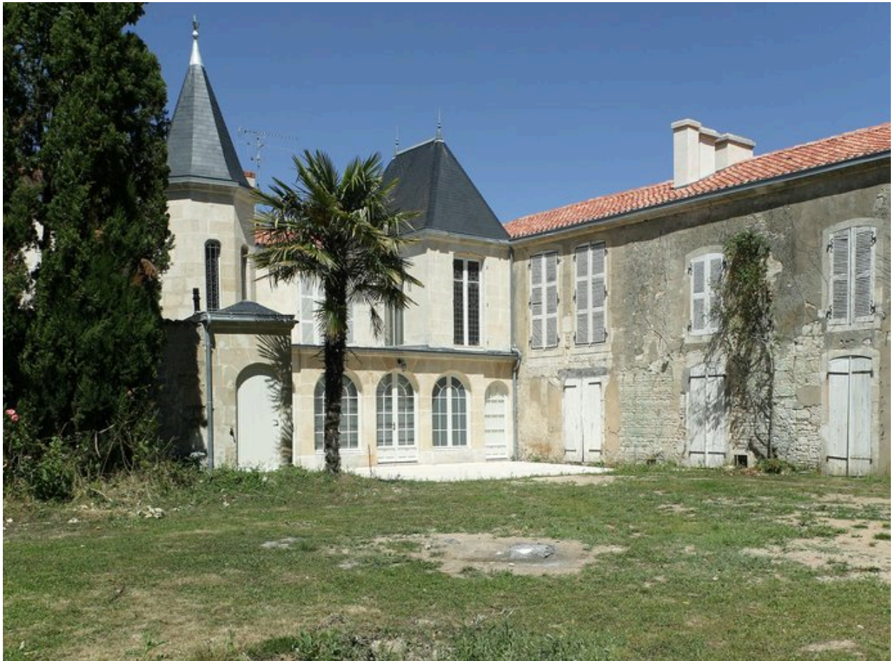
Façades donnant sur le jardin (vue prise du sud-ouest).
