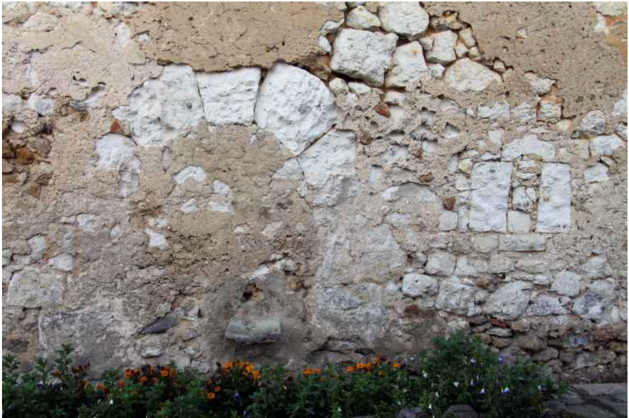
Façade antérieure sur cour : arc en plein cintre couvrant une niche intérieure.
