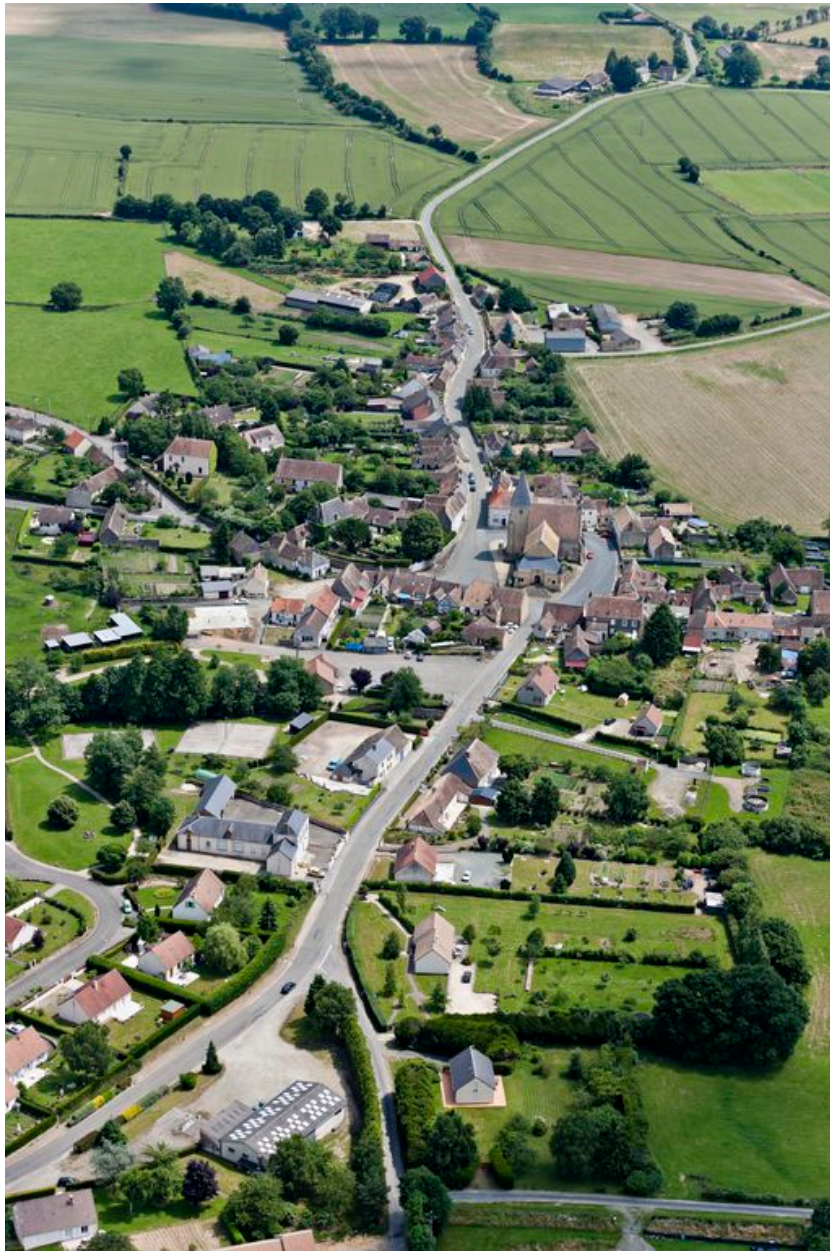
Vue aérienne depuis l'ouest.
