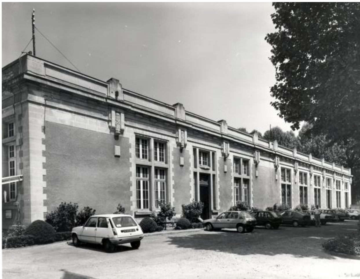
Nouveaux ateliers d'ajustage et forge (par Bricard) : élévation est, sur la cour principale de l'Ecole.
