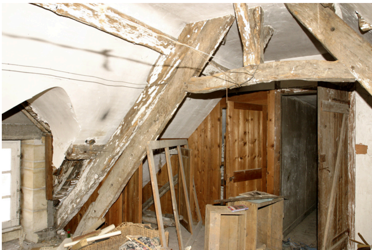
Charpente de l'aile sud, détail de la pièce est (XVIIe siècle).
