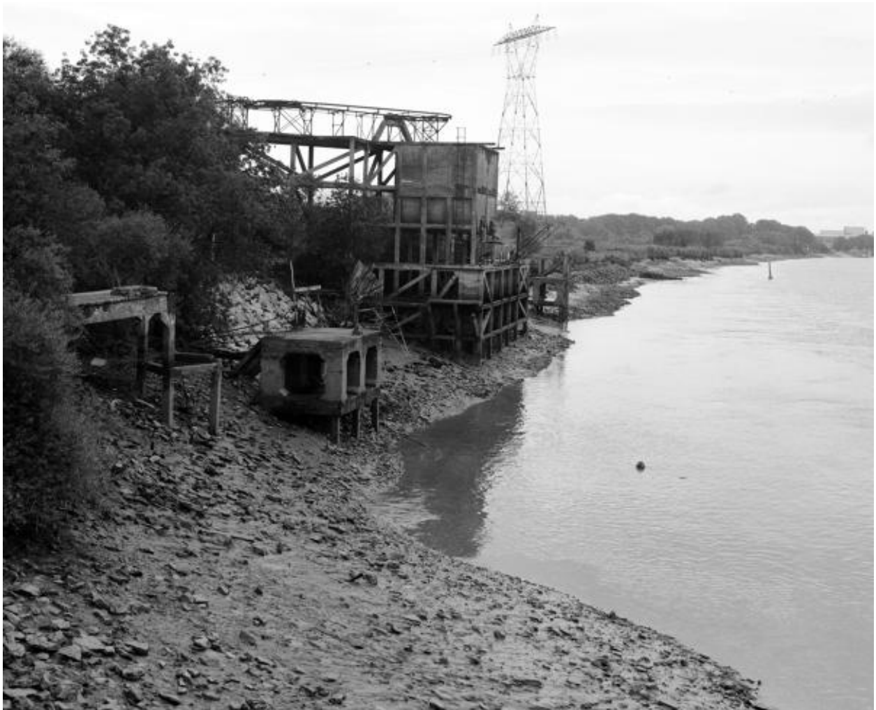
Vue générale du poste de chargement (état en 1997).
