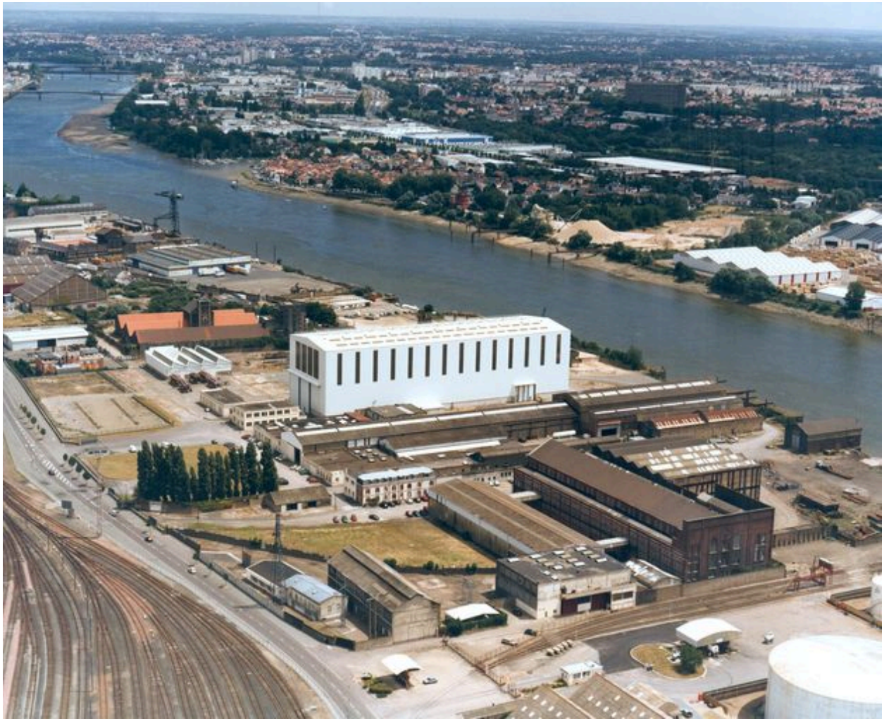
Vue aérienne du site de Leroux et Lozt.
