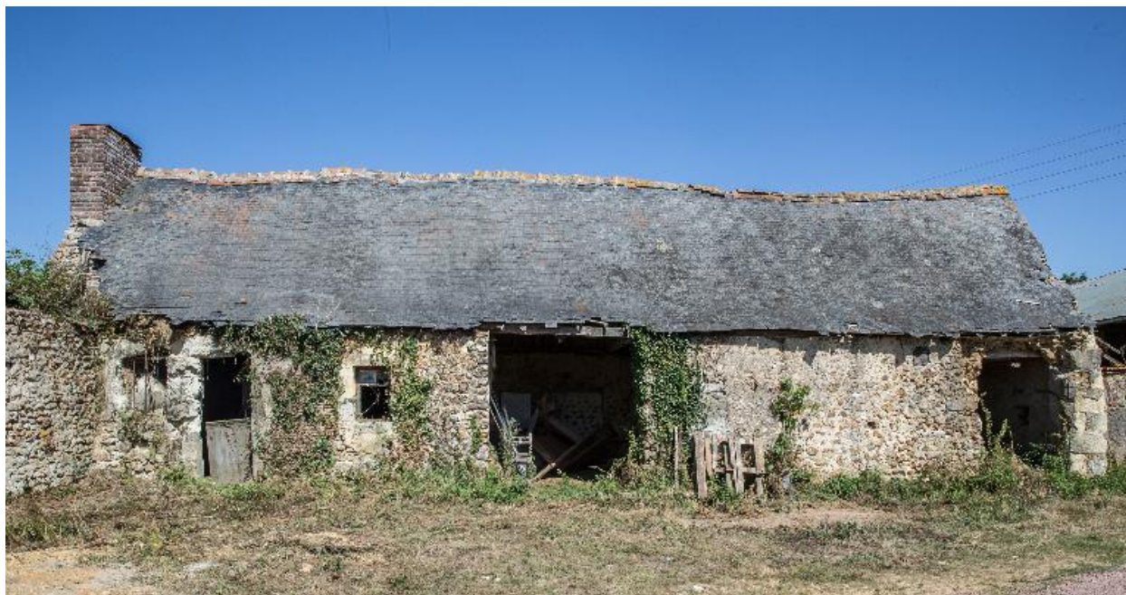
La ferme ancienne, façade antérieure.
