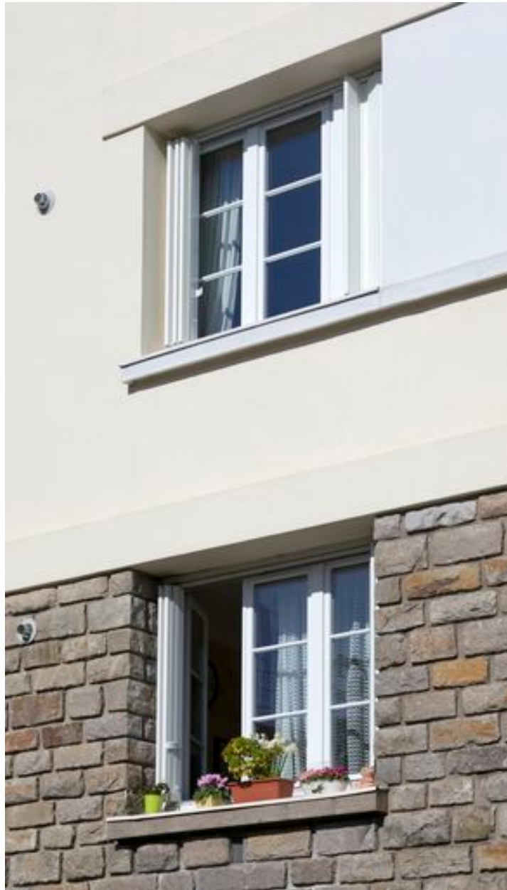
Fenêtres 1er et 2ème étages, Bâtiment A.
