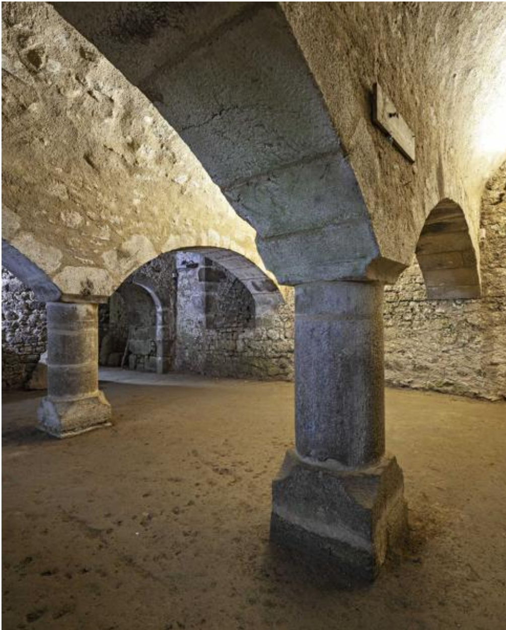
Cave du corps de logis nord-ouest.
