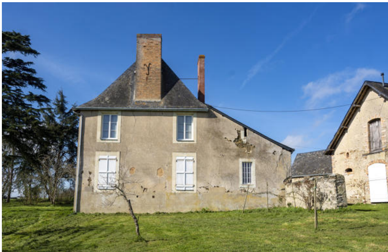
La façade latérale du logis.
