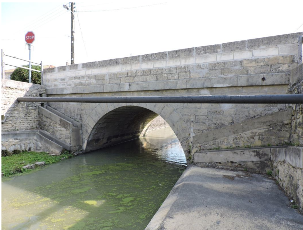
Le pont côté aval, vu depuis le sud.
