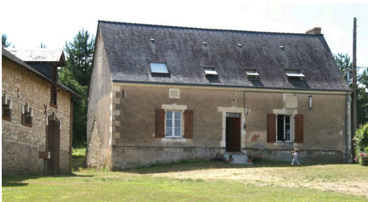
Maison d'habitation, façade sur cour : comble à surcroît.
