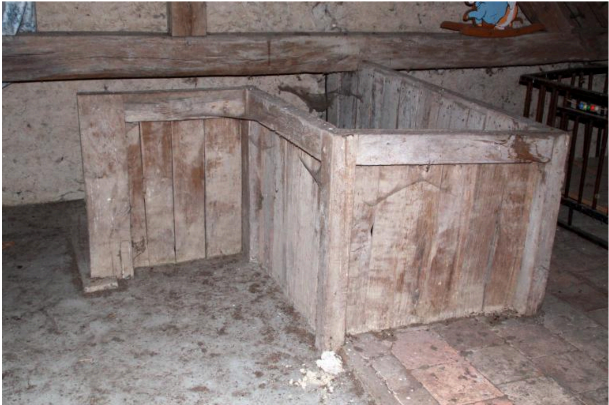
Maison, comble : garde-fou de l'escalier.
