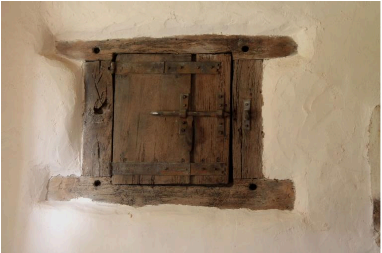
Maison, placard mural à gauche de la cheminée.
