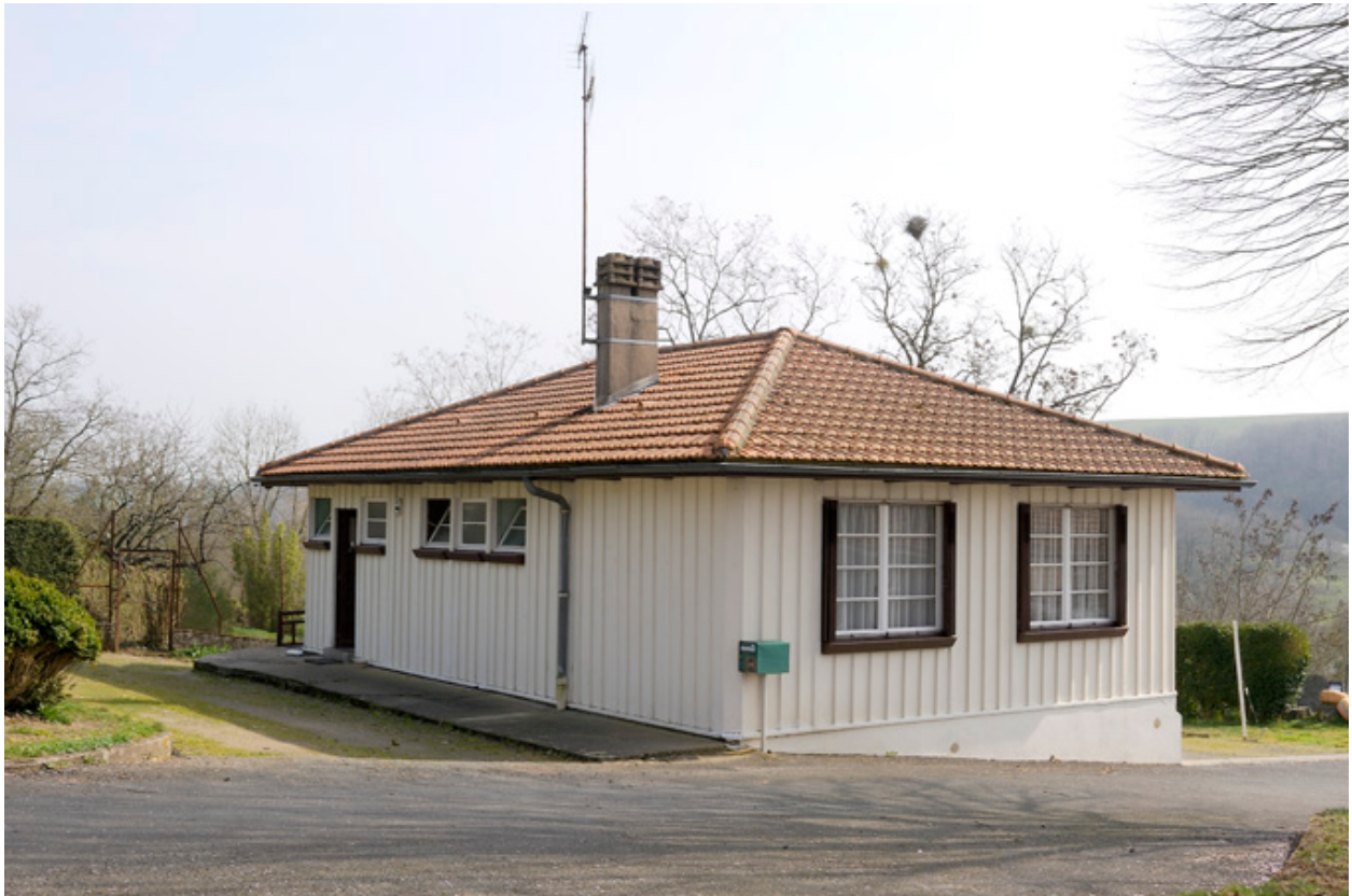
Maison de type semi-métallique (une unité d'habitation), située au 28 rue de Gaudu.
