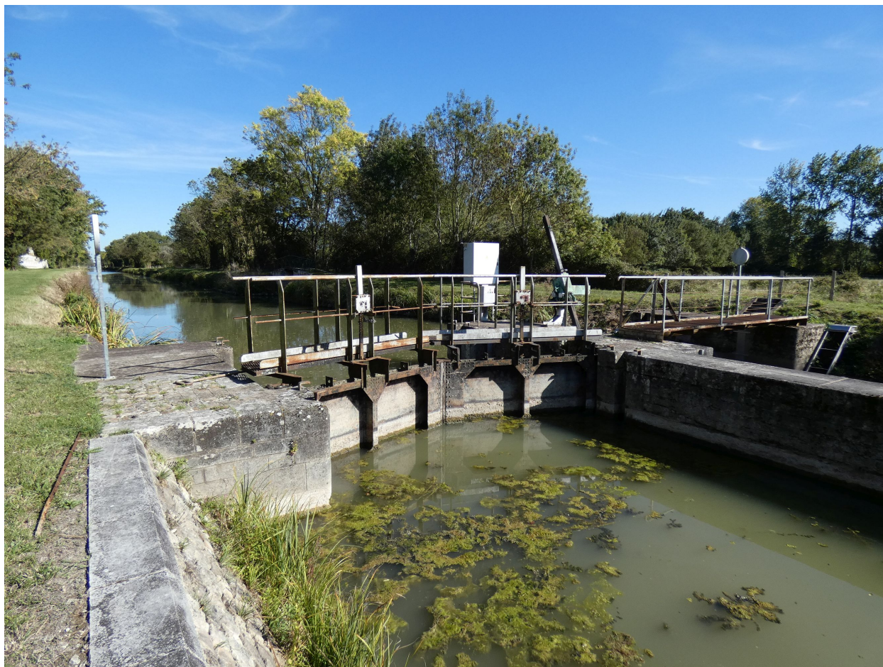
La porte amont de l'écluse vue depuis l'aval.
