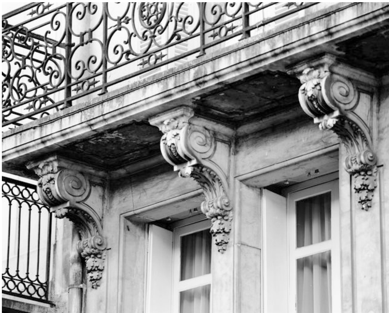
Elévation antérieure, 1ère travée : consoles du balcon continu du 3e niveau.
