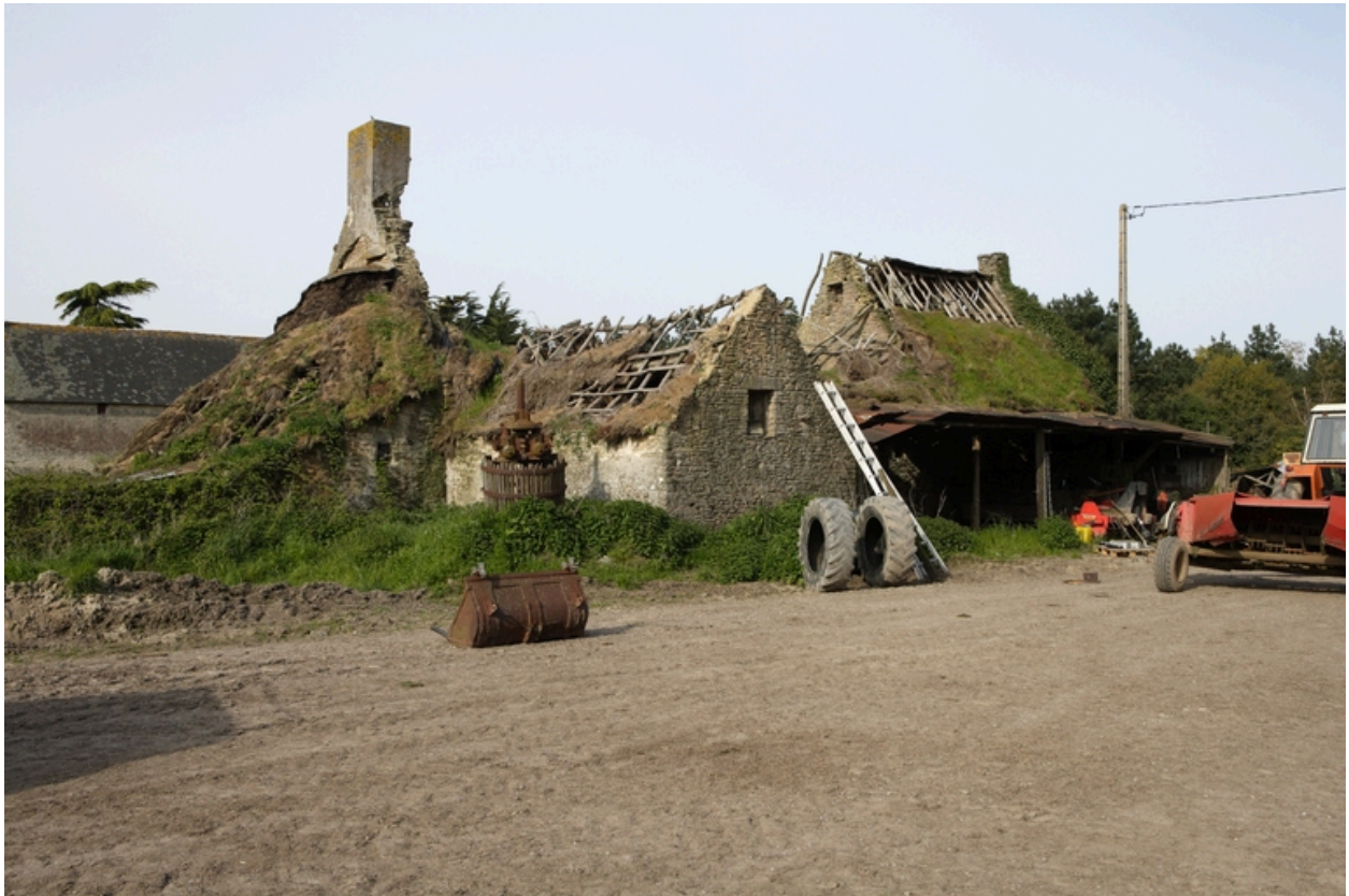
Vue de l'étable sur le mur goutterau nord.
