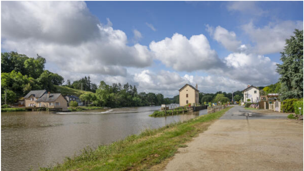
L'écluse et le barrage de Neuville.
