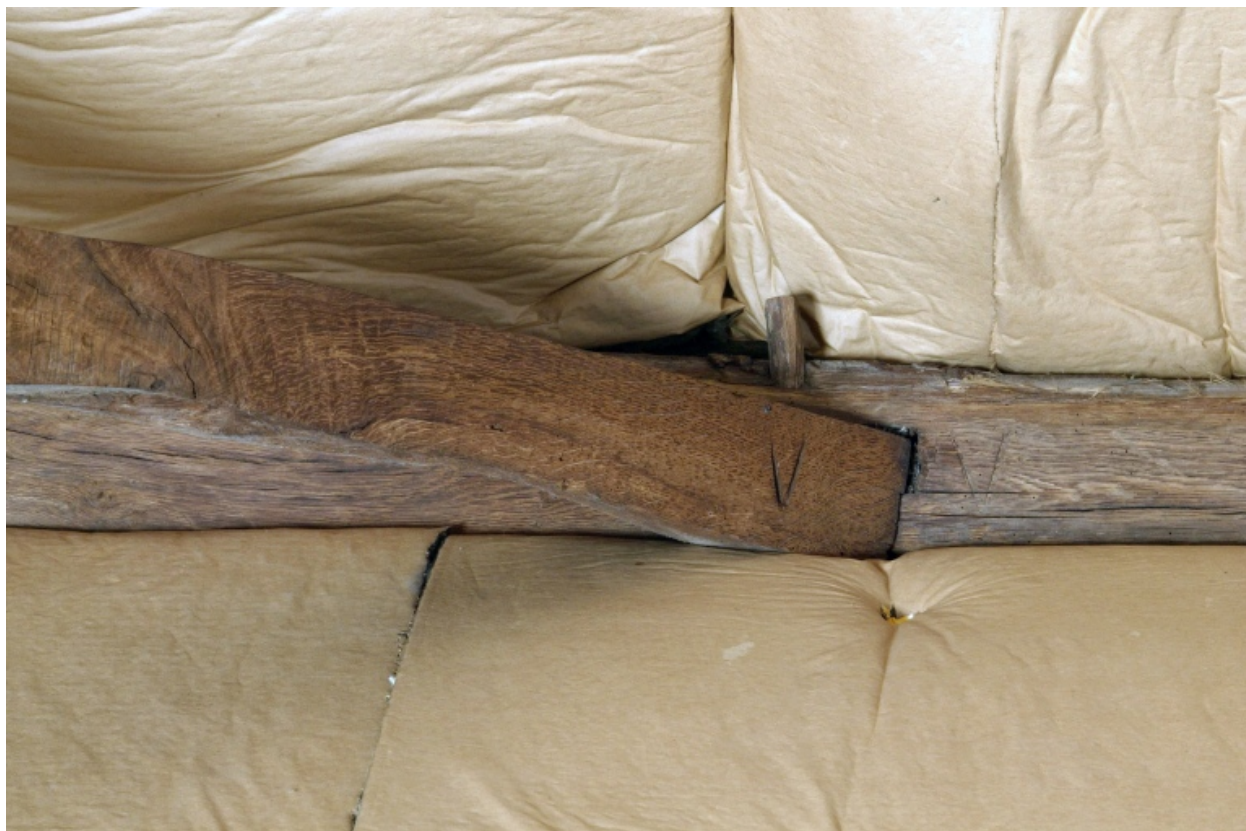
Charpente du bâtiment perpendiculaire à la rue, détail de marques d'assemblage.
