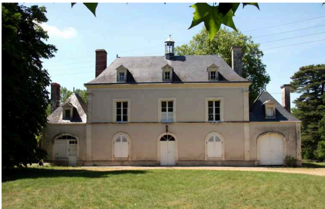
Façade antérieure sur cour.
