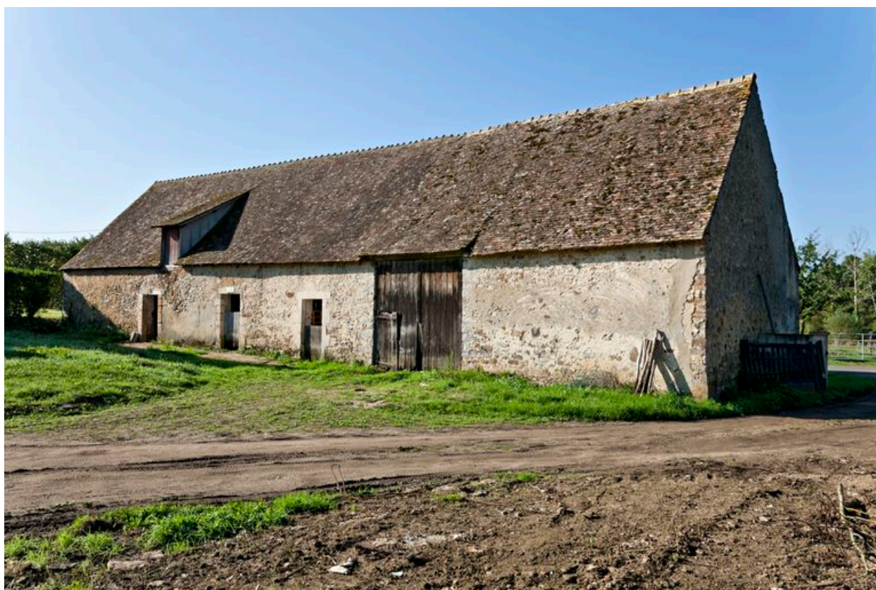
Elévation sur cour de la grange-étable-fenil.
