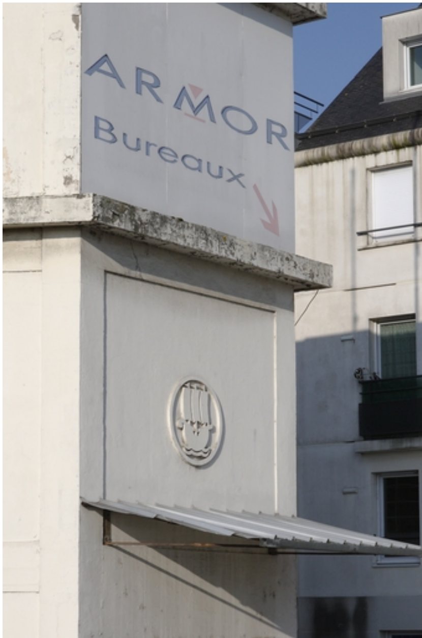
Détail de la façade avec le logo de l'entreprise sculpté.
