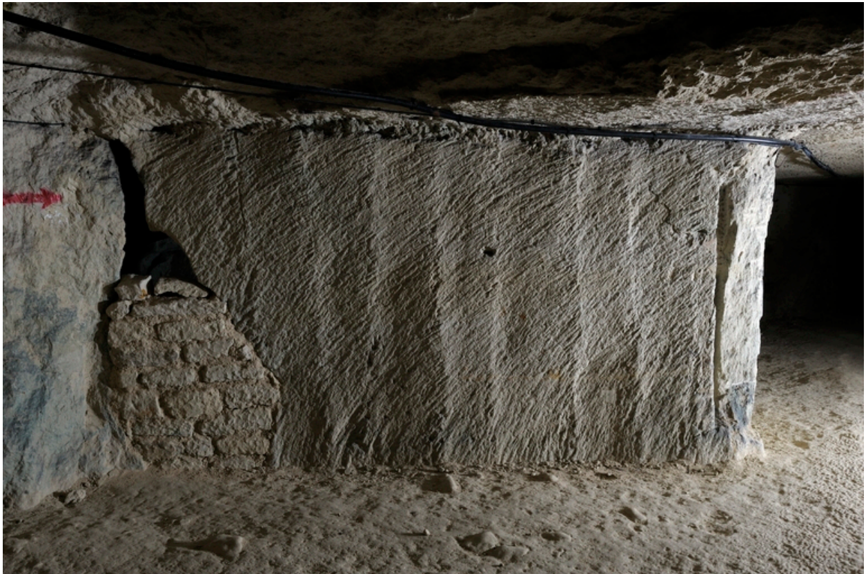
Saut-aux-Loups. Ancienne carrière : saignées successives témoignant de la progression de l'extraction des dalles de tuffeau.
