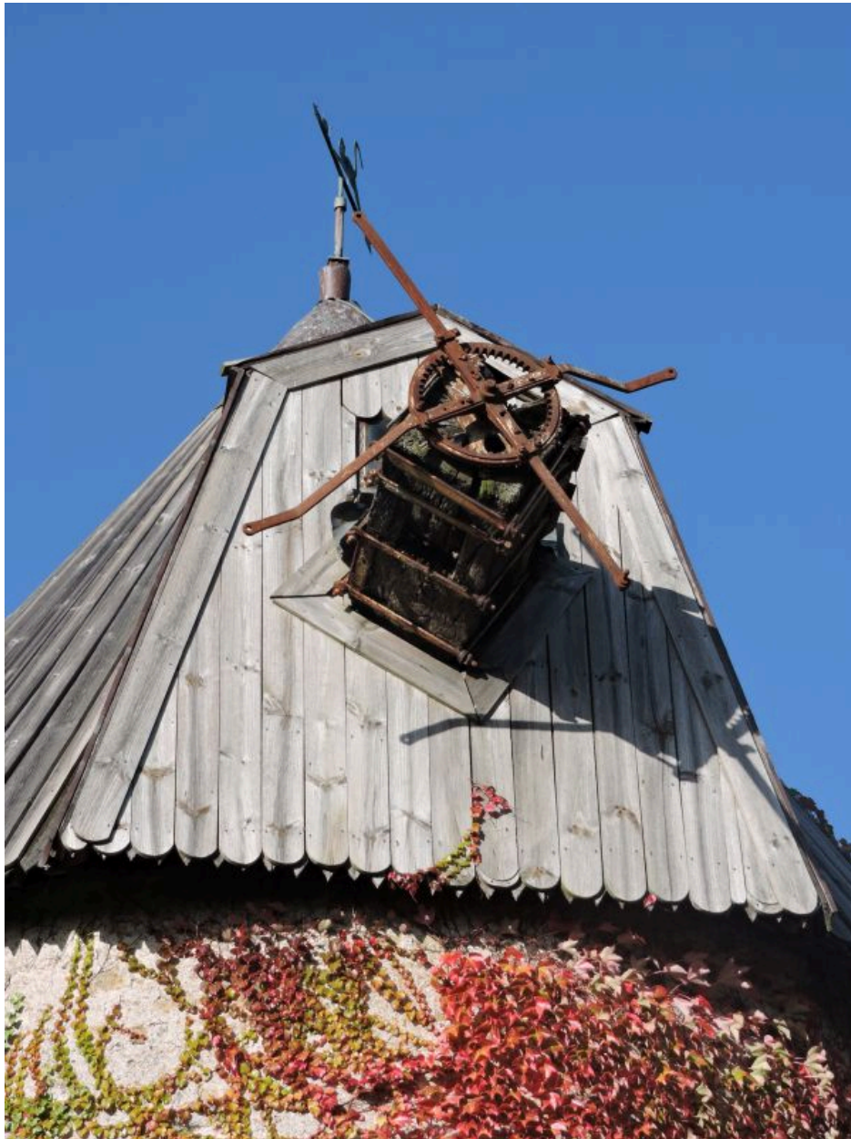
L'extrémité de l'arbre avec des vestiges d'ailes de type Berton.
