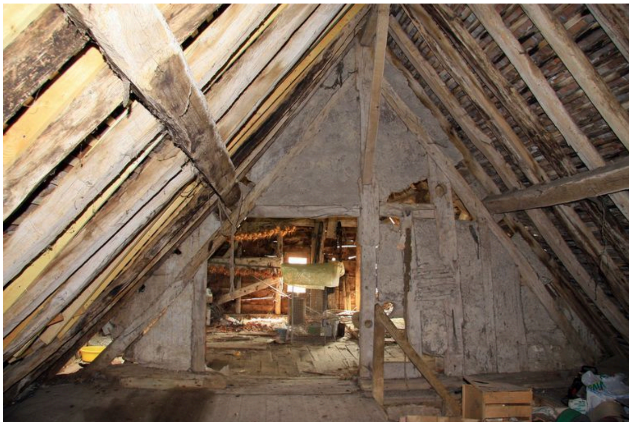
Le moulin, maison d'habitation, grenier : pignon en pan de bois et charpente à pannes.
