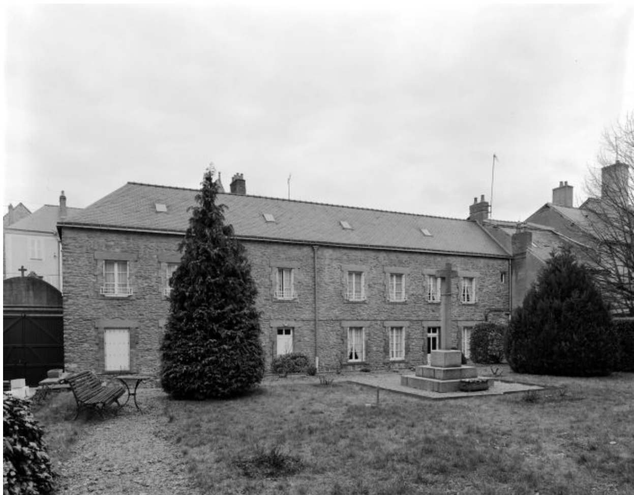
Première cour latérale nord, bâtiment sur rue : élévation sur la cour.
