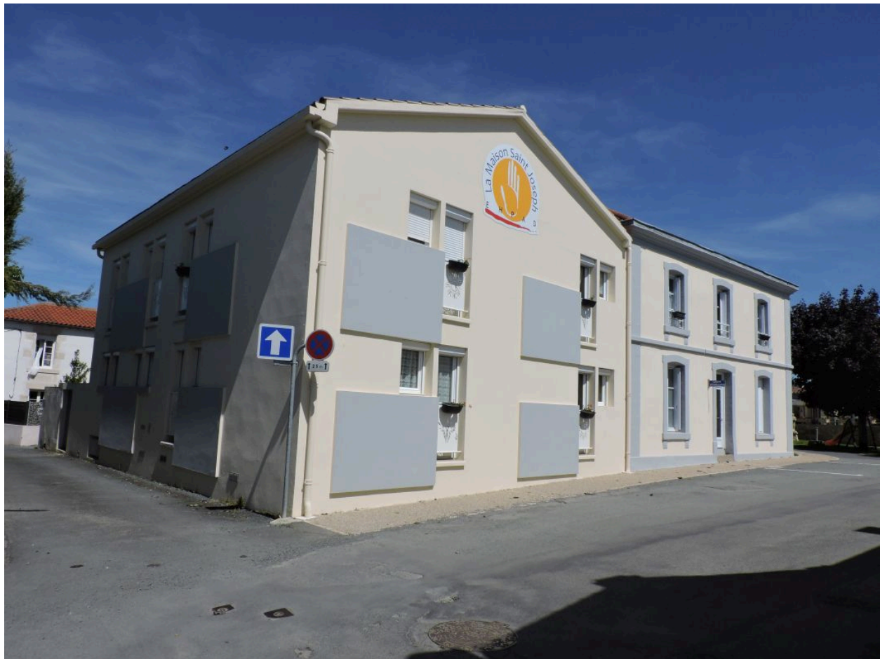
La maison de retraite vue depuis le sud-ouest, à l'angle entre la rue de la Fontaine et la rue Pousse Fenouil.
