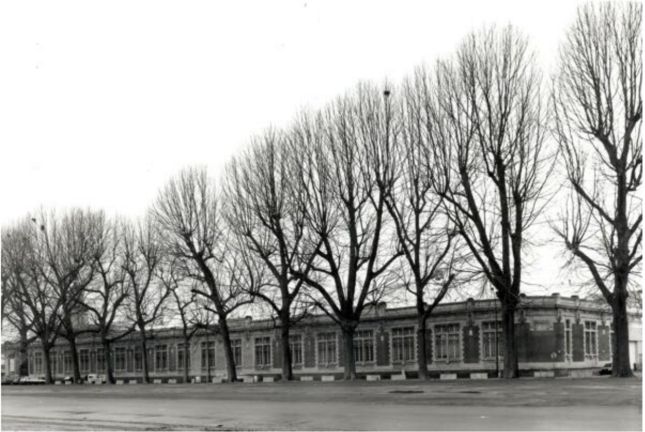
Nouveaux ateliers d'ajustage (par Bricard) : vue d'ensemble sur le boulevard Arago et la rue Godard-Faultrier.
