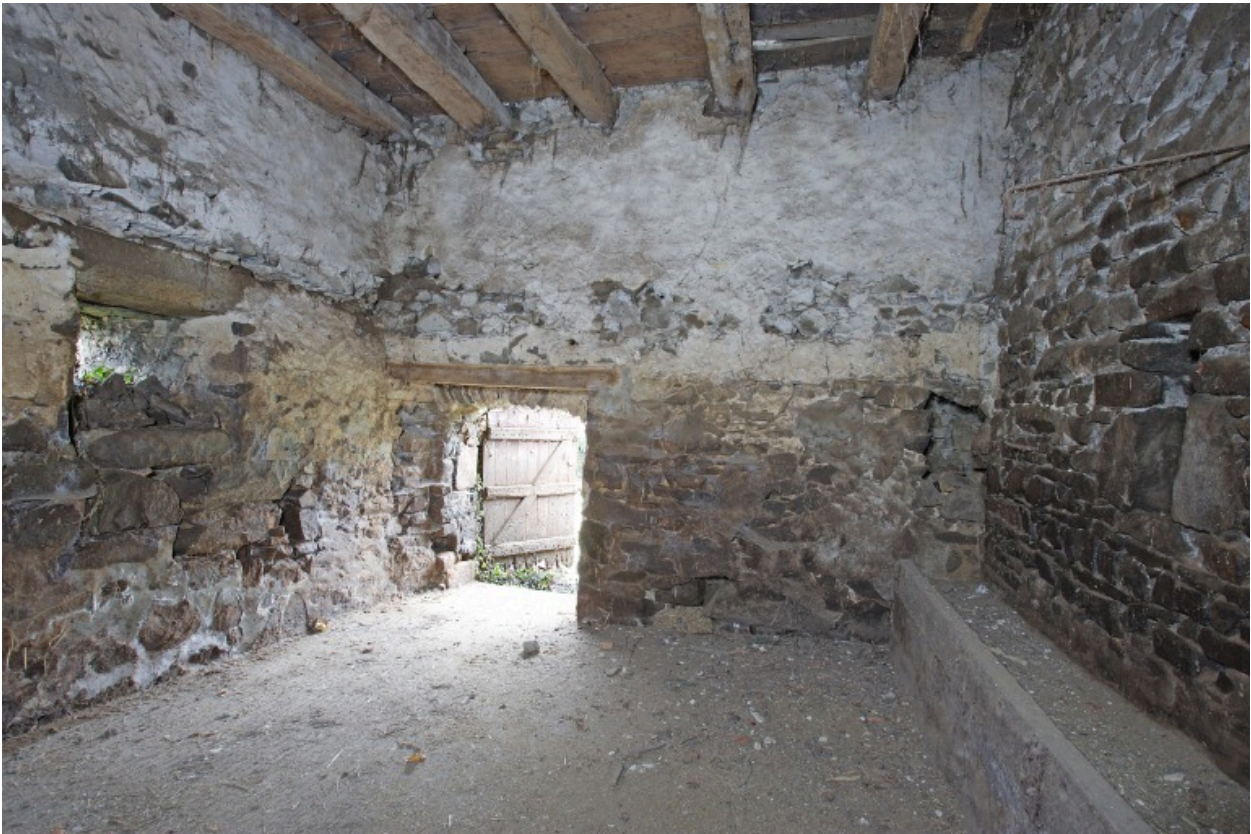
La chapelle, vue intérieure. Partie est du rez-de-chaussée, transformée en étable, vue depuis le nord.
