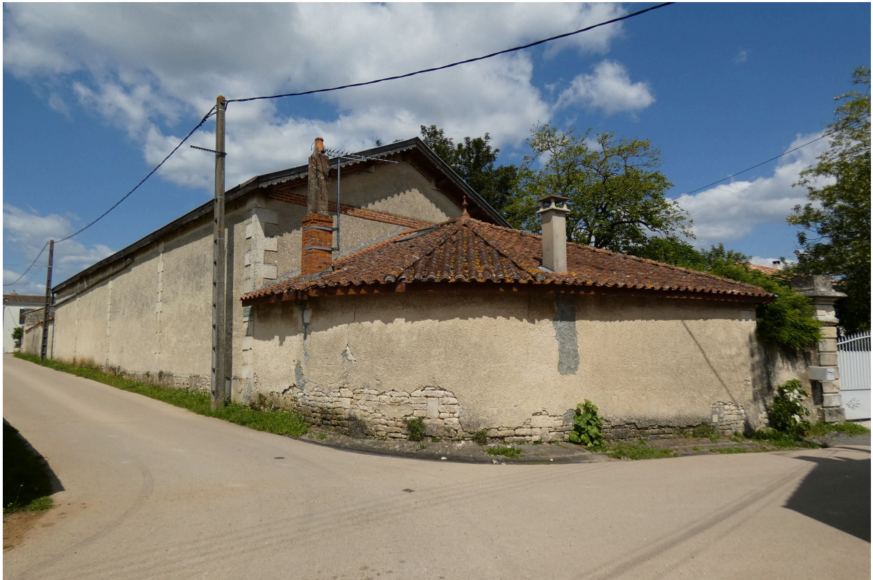
Les communs et l'écurie vus depuis l'ouest.
