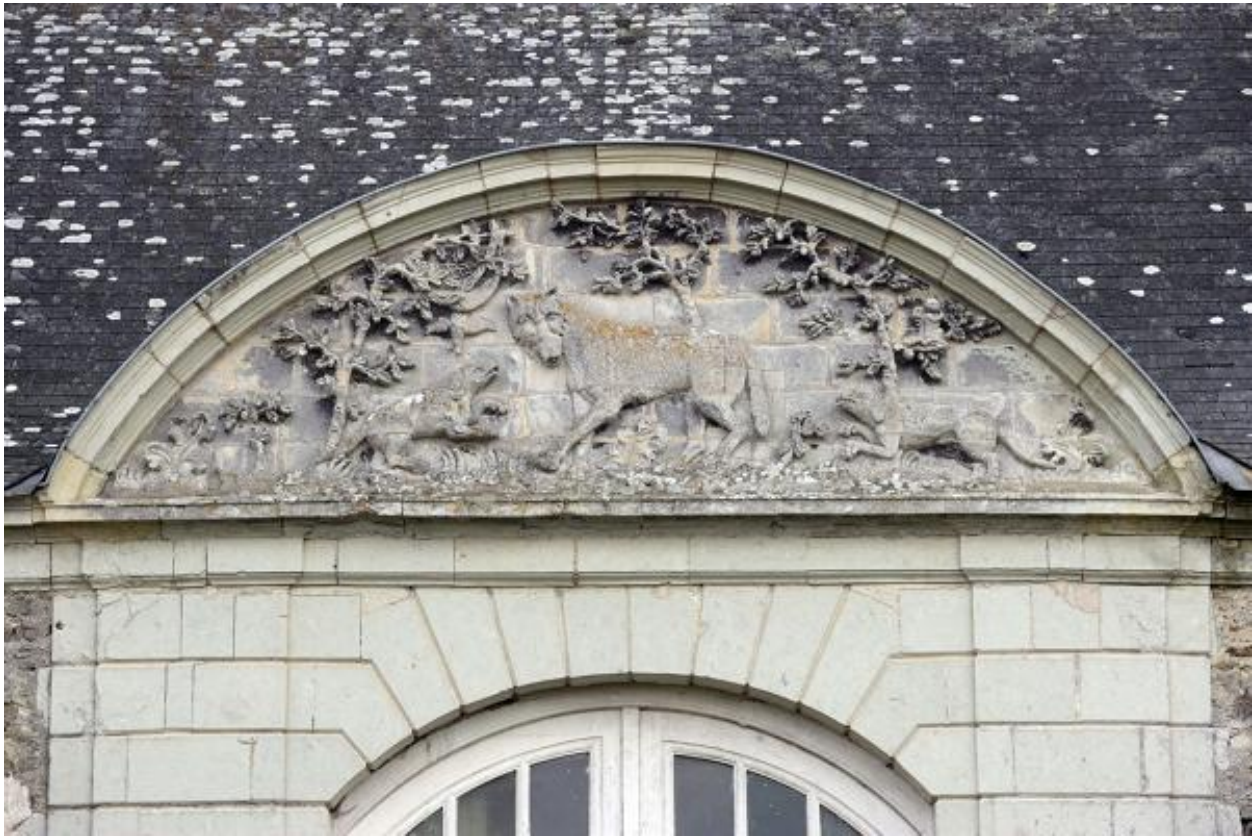
L'aile de commons sud, fronton sculpté de l'élévation antérieure.
