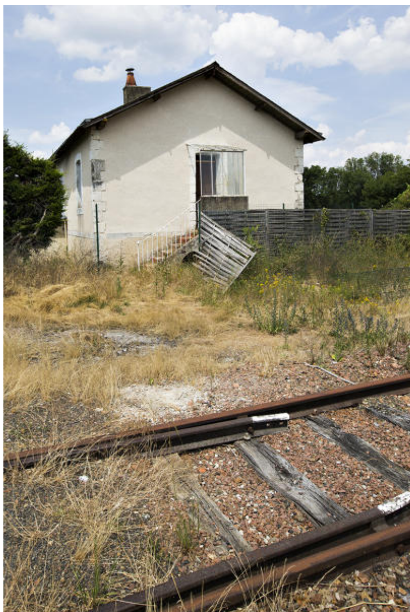
Chahaignes : maison de garde-barrière.
