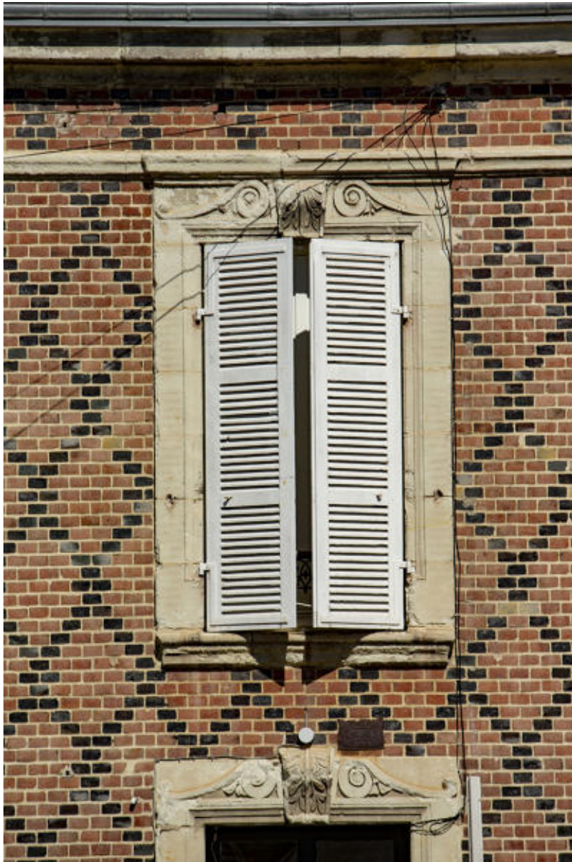
Un détail de la façade.
