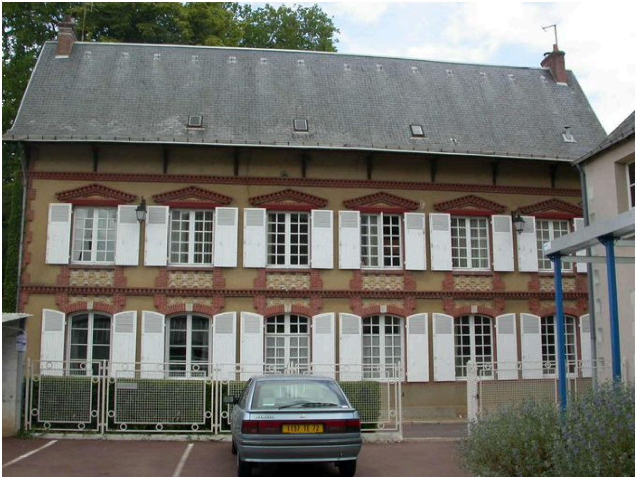
Elévation antérieure du logement (patronal ?) E.
