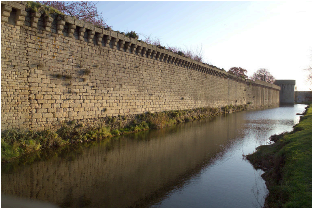
Enceinte urbaine et tour de l'Abreuvoir.
