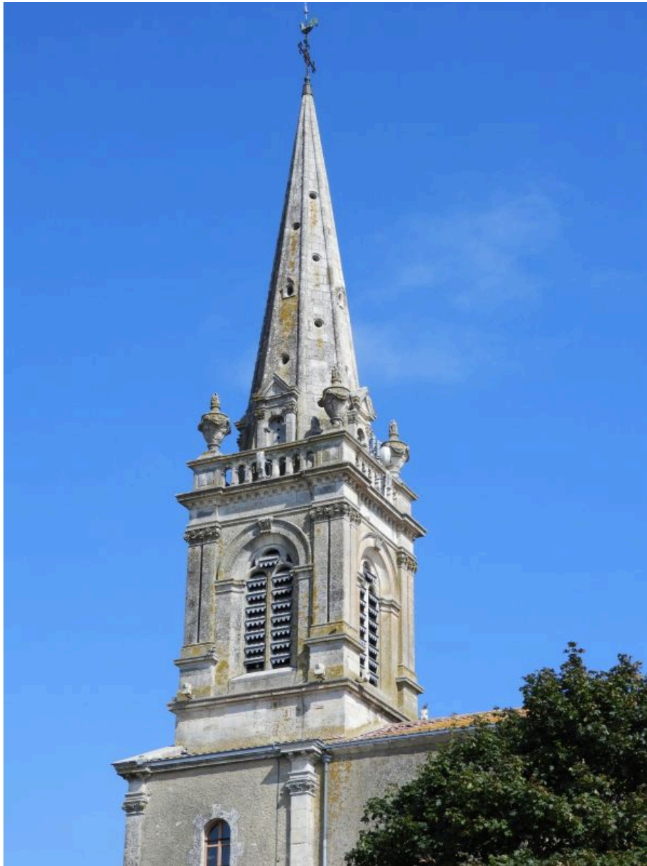
Le clocher vu depuis le sud-est.
