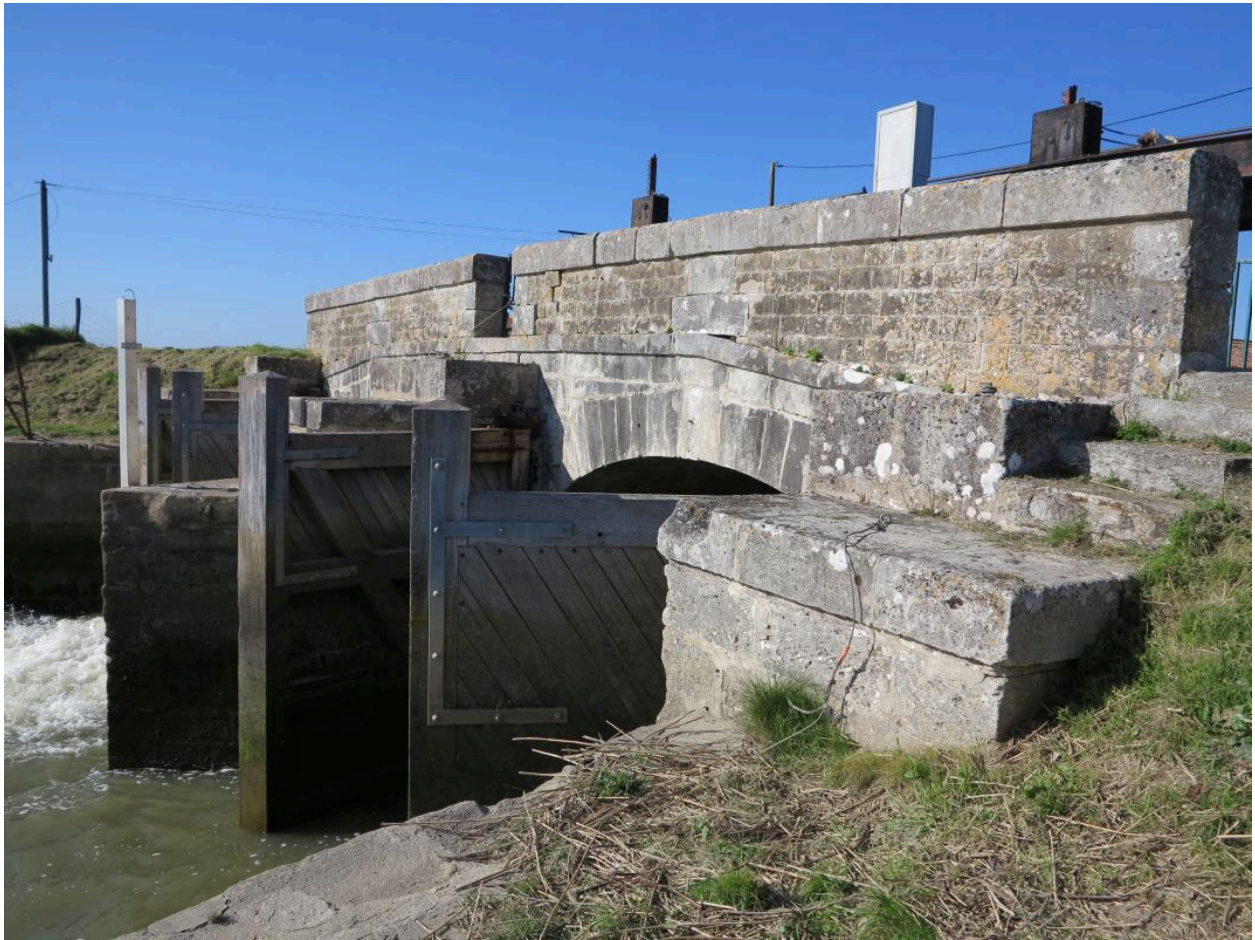
La porte vue depuis le sud, rive gauche.
