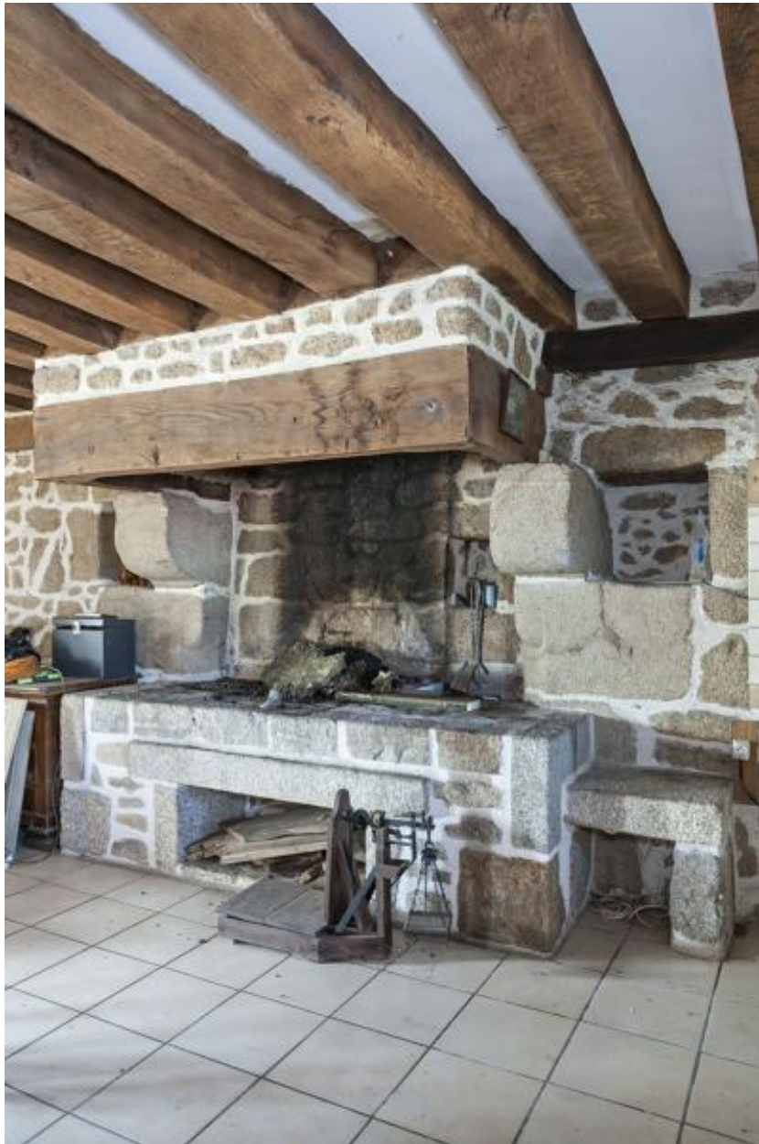
Cheminée du logis de ferme.
